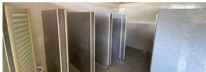
Escola Classe 50: Reforma dos banheiros em andamento
