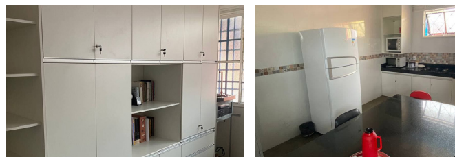
Escola Classe 46: Instalação de armários na sala de coordenação e reforma na copa
