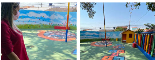
Escola Classe 510: Construção da área de lazer
