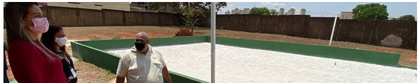
Centro de Ensino Fundamental 507: Estruturação da área de entrada e convívio e construção da quadra de areia
