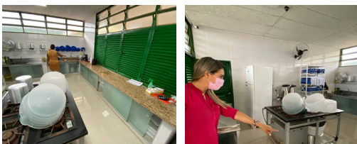
Escola Classe 419: Reforma da cantina e secretaria
