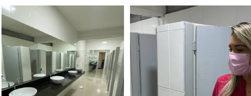
Centro Ensino Médio 414: Reforma nos banheiros
