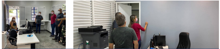
Centro de Ensino Fundamental 504: Reforma da secretaria
