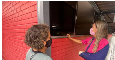
Centro de Ensino Médio 01: Substituição das janelas por blindex
