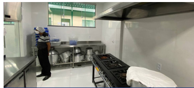
Centro de Ensino Especial 01: Reforma completa da cozinha com ampliação do espaço
