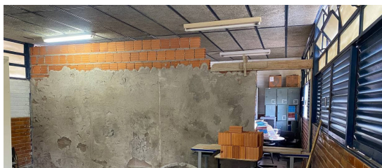
Centro de Ensino Fundamental 03: Reforma da biblioteca - em construção
