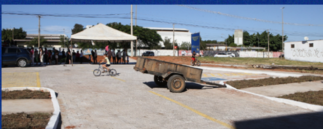
Construção de estacionamento na QR 103
