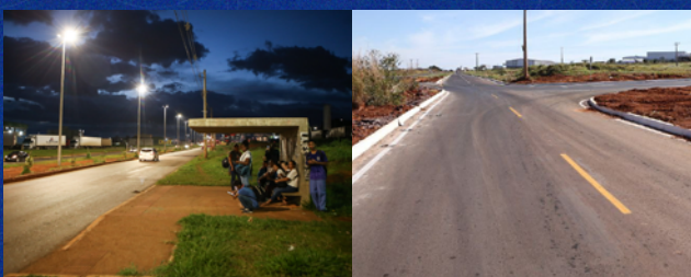
Melhorias no Polo JK (drenagem, calçamento, iluminação, subestação de energia, pavimentação, praça e ciclovia)
