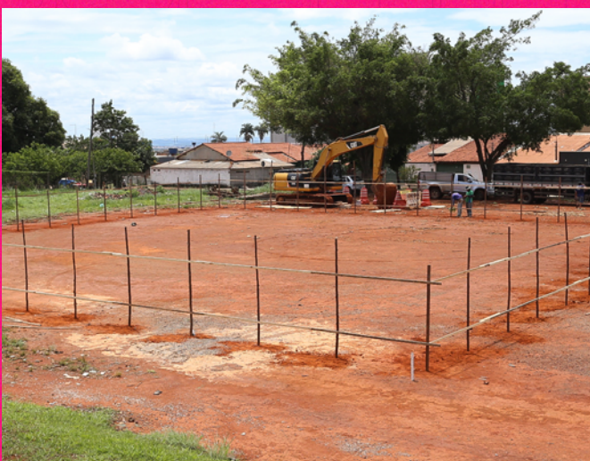
Pavimentação do Residencial Santa Maria
