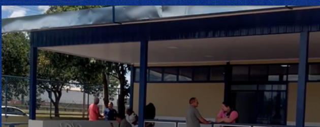
Construção do Centro de Convivência do Idoso (CCI) em Santa Maria
