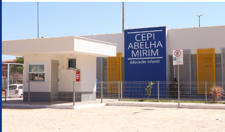
Construção da creche pública na QR 215/315
