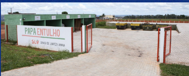
Construção de dois papa-entulho na AC 104 e QR 219
