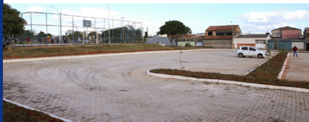
Recapeamento da Avenida Alagados
