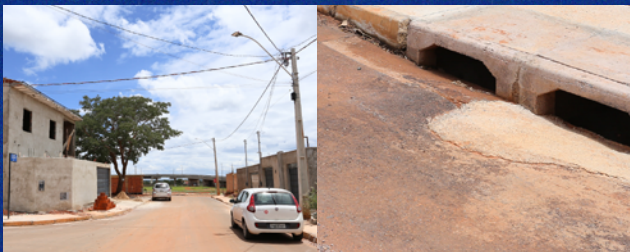
Construção da rede de esgoto, pavimentação, drenagem e implantação da rede elétrica, além da iluminação, na QR 119
