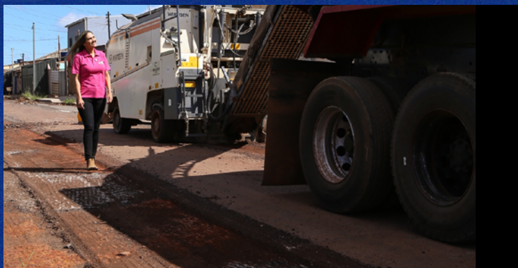
Recapamento das vias de acesso às quadras 416/417 e 516/517/518 até a 219
