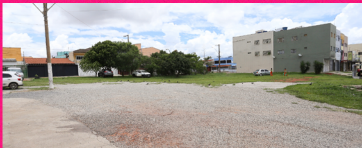
Construção de estacionamento na CL 210 (obra em andamento)
