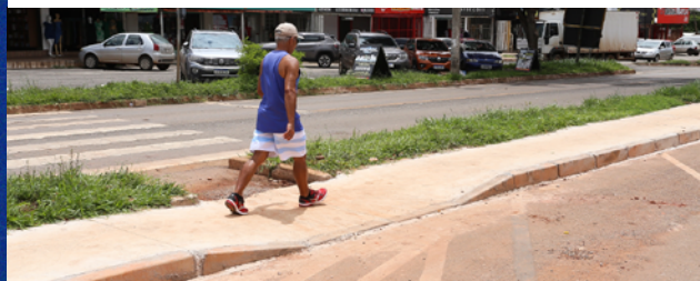
Construção de calçadas com acessibilidade em diversos pontos da cidade
