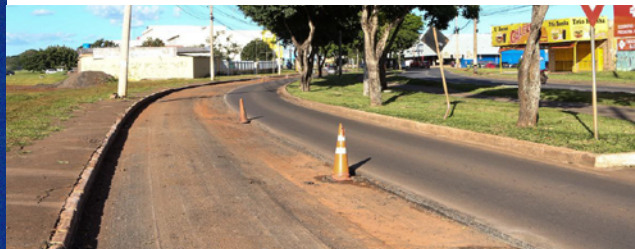
Pavimentação e iluminação da vicinal 371, com ciclovia
