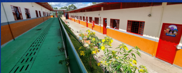
Reforma da Escola Classe Porto Rico, obra que se arrastava há 6 anos
