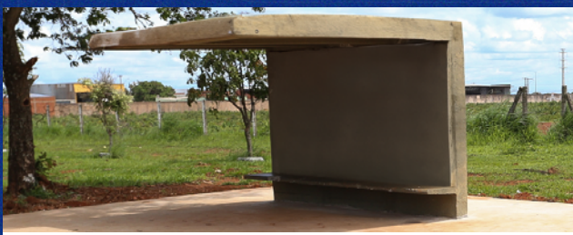
Substituição e instalação de novos abrigos para passageiros nas linhas de ônibus
