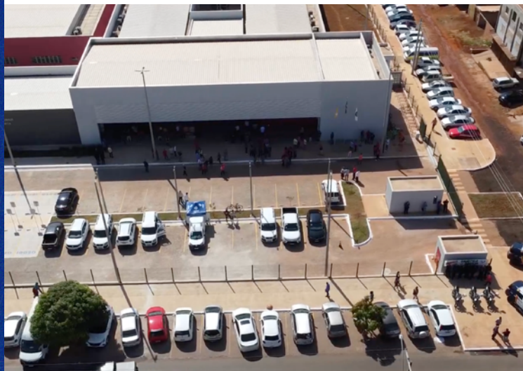
Construção da Escola Técnica de Santa Maria
