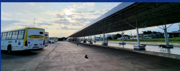
Construção do terminal rodoviário na QR 402
