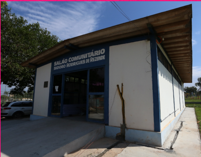
Reforma do salão comunitário do DVO
