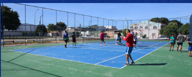
Construção da quadra de tênis na QR 116
